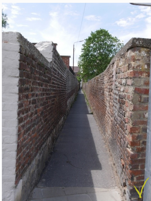
Venelle en bon état et accessible aux PMR
