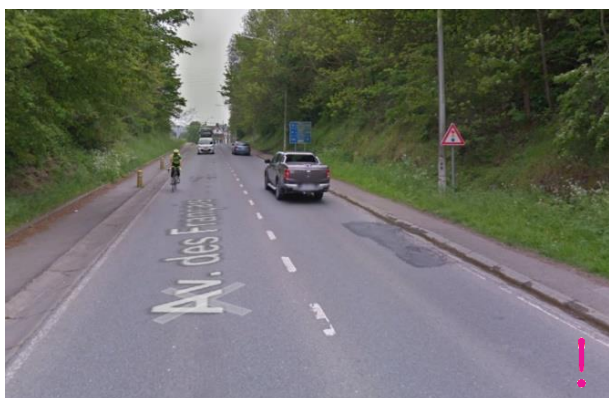
Absence ou insuffisance des aménagements piétons et PMR le long des nationales – Rue de Fosses (Falisolle) / Avenue des Français (Tamines)
