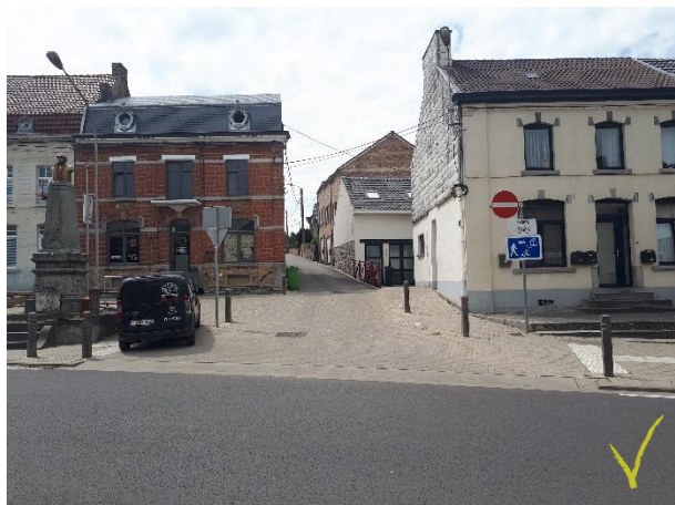
Réaménagement en faveur des piétons dans le centre de Falisolle : revêtement distinctif, trottoir large, potelets, zone 20 et dalles podotactiles
