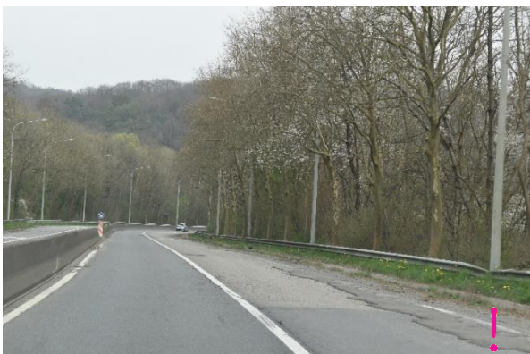
N90 (réduite en 2x1 bande au vu de l'état du revêtement)
