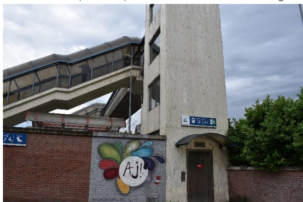
Accès PMR par ascenseur aux voies et passage pour les piétons vers l'autre côté de la gare
