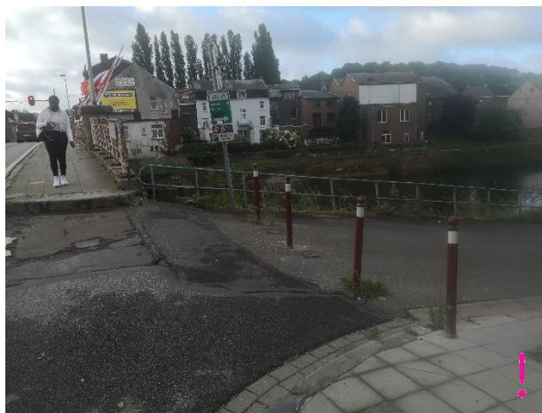
Passage du Ravel sur le Pont à Taminés : absence de continuité
