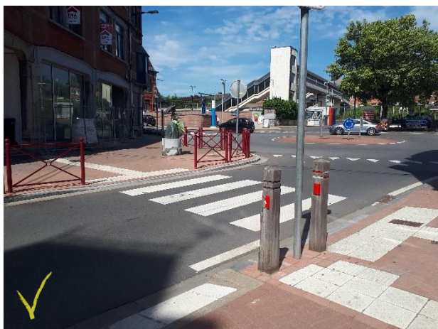
Tamines – croisement Lagneau – Station : réaménagement en faveur des piétons et PMR
