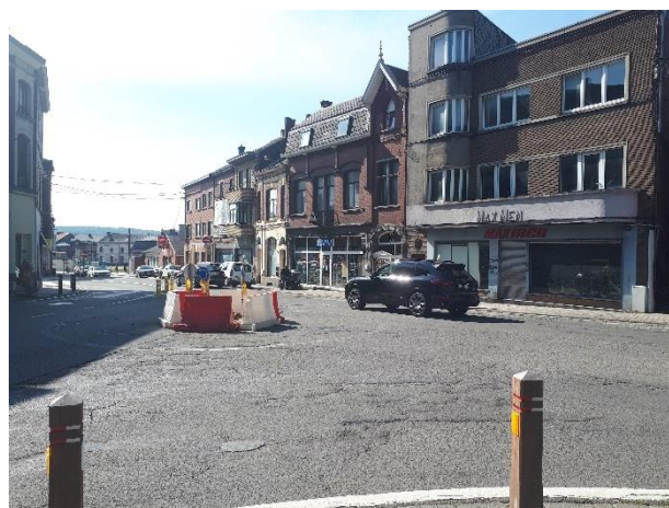
Test de giratoire en cours entre Bachères et N988 à Tamines
