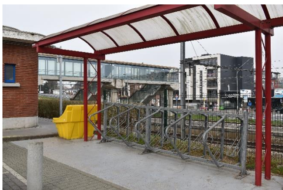
Stationnement cyclable en gare d'Auvélais
