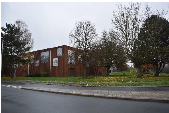
Le hall omnisport d'Auvelais
