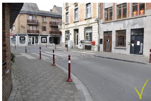
Auvélais - Rue de l'Hôtel de Ville : traversée sécurisée et accessible aux PMR
