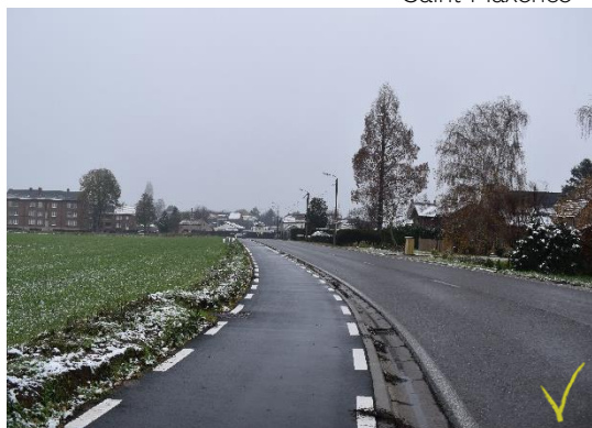
Chevrons verts manquant de visibilité rue du Pont Saint-Maxence
