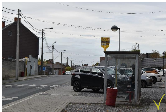
Arrêt de bus « Monument » à Tamines, en recul de la voirie et équipé d'infrastructures d'attente
