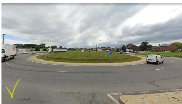
Réaménagement du carrefour entre la N912 et N98 à Velaine en rond-point
