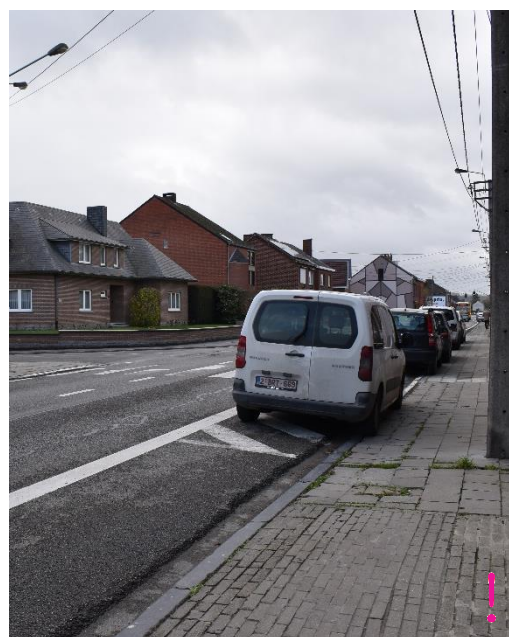
N930 : trottoirs étroits, voitures empiétant sur le trottoir, traversée peu visible...
